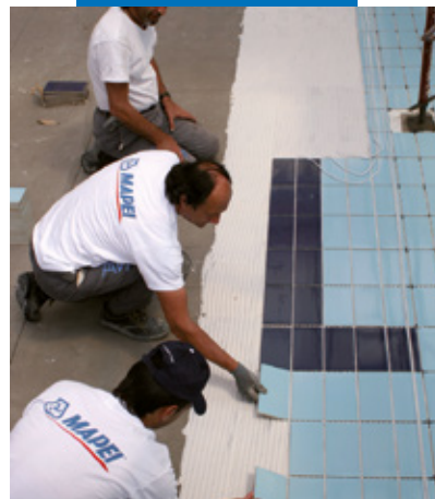
Posa di rivestimento ceramico su Mapelastic
