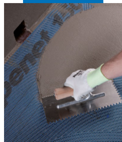
Stesura di Mapelastic su Mapetex 150
