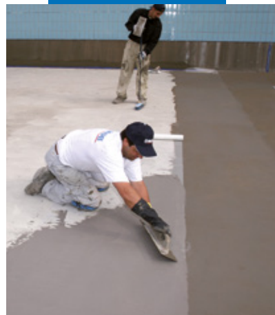
Impermeabilizzazione di una piscina con Mapelastic
